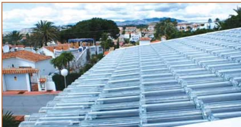
El sistema **SolTech Energy** para generar energía limpia y sostenible, tejas solares de vidrio está proliferando, según EcoInventos. Se trata de una innovación sueca con la que se puede reducir los costes en calefacción, un sistema único de calefacción con tejas fabricadas con vidrio transparente.
